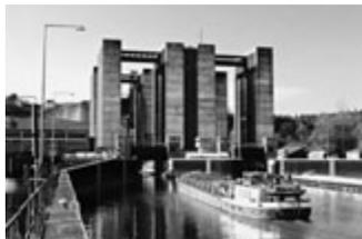
Am Elbe-Seitenkanal, in Scharnebeck bei Lüneburg, steht Deutschlands größtes Schiffshebewerk, das 1974 als das größte der Welt in Betrieb genommen wurde. Wie in einem riesigen Fahrstuhl überwinden dort die Frachtschiffe in zwei 100m langen wassergefüllten Trögen einen Höhenunterschied von 38m - von der Elbmarsch auf die Geest und in umgekehrter Richtung.
